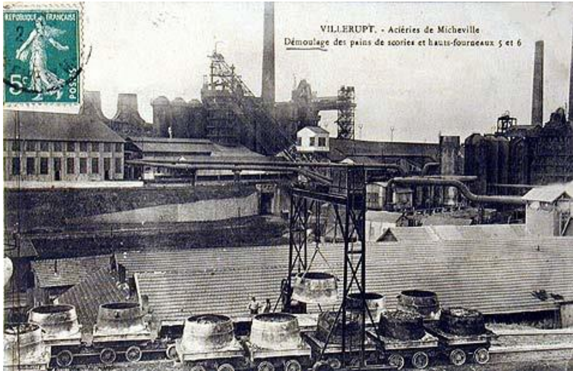
Villerupt - Aciéries de Micheville: Démoulage des pains de scories et hauts-fourneaux 5 et 6 (Collection: Marcel Fritsch) image tirée du site industrie.lu
