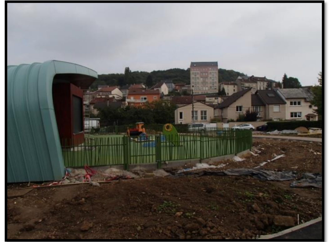
Photographie du 26/09/2013 à Audun-le-Tiche – Groupe 8, « travaux pour la nouvelle crèche ».
